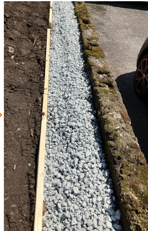
⑥暗渠パイプ上に砂利を被覆
