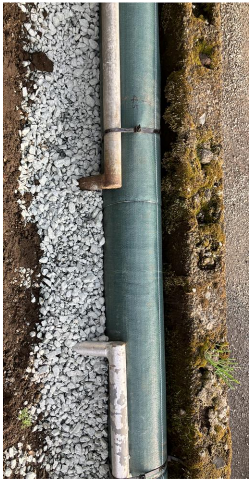
③砂利を暗渠パイプの下に敷く
