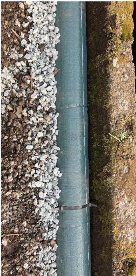
④梁が隠れるように砂利で覆う
